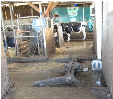
Bild 1a) Schieberbahnhof im Bereich des Querganges
