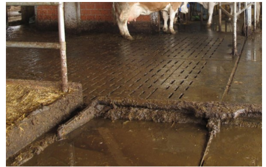
Bild 1c) Schieberbahnhof am Übergang vom Laufhof zum Wartebereich
